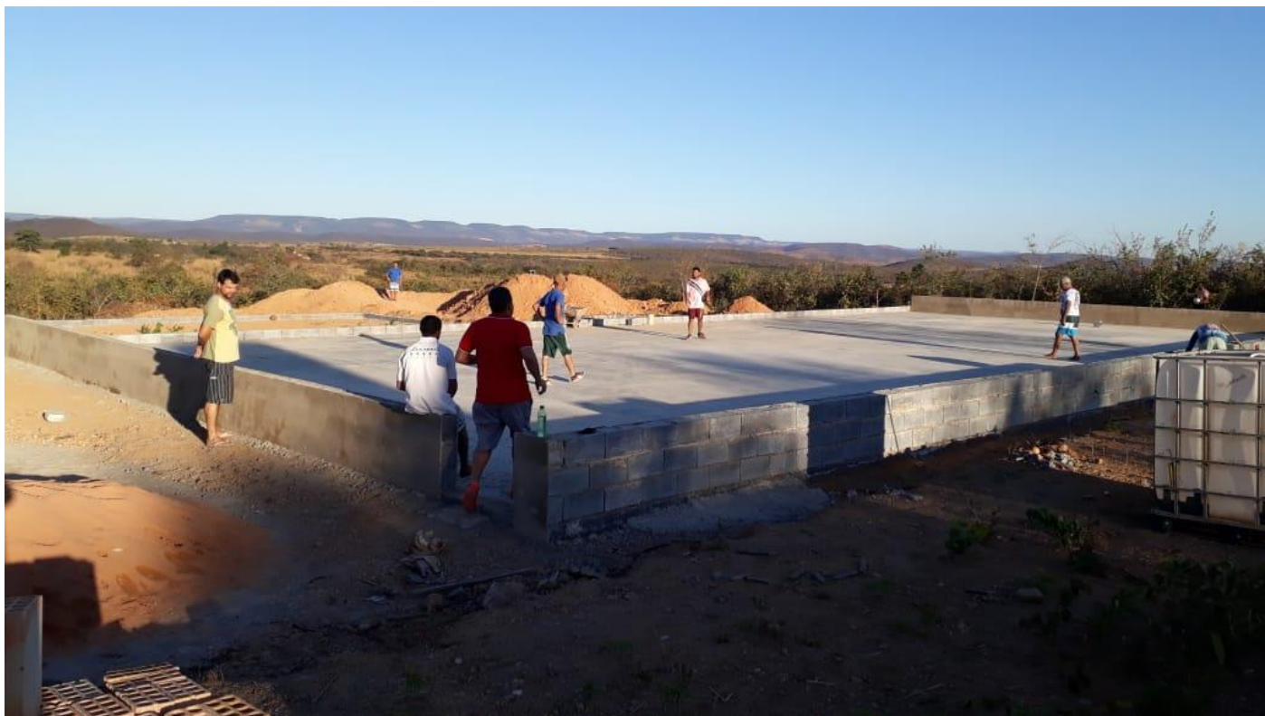
INICIO DA CONSTRUÇÃO DA QUADRA POLIESPORTIVA
