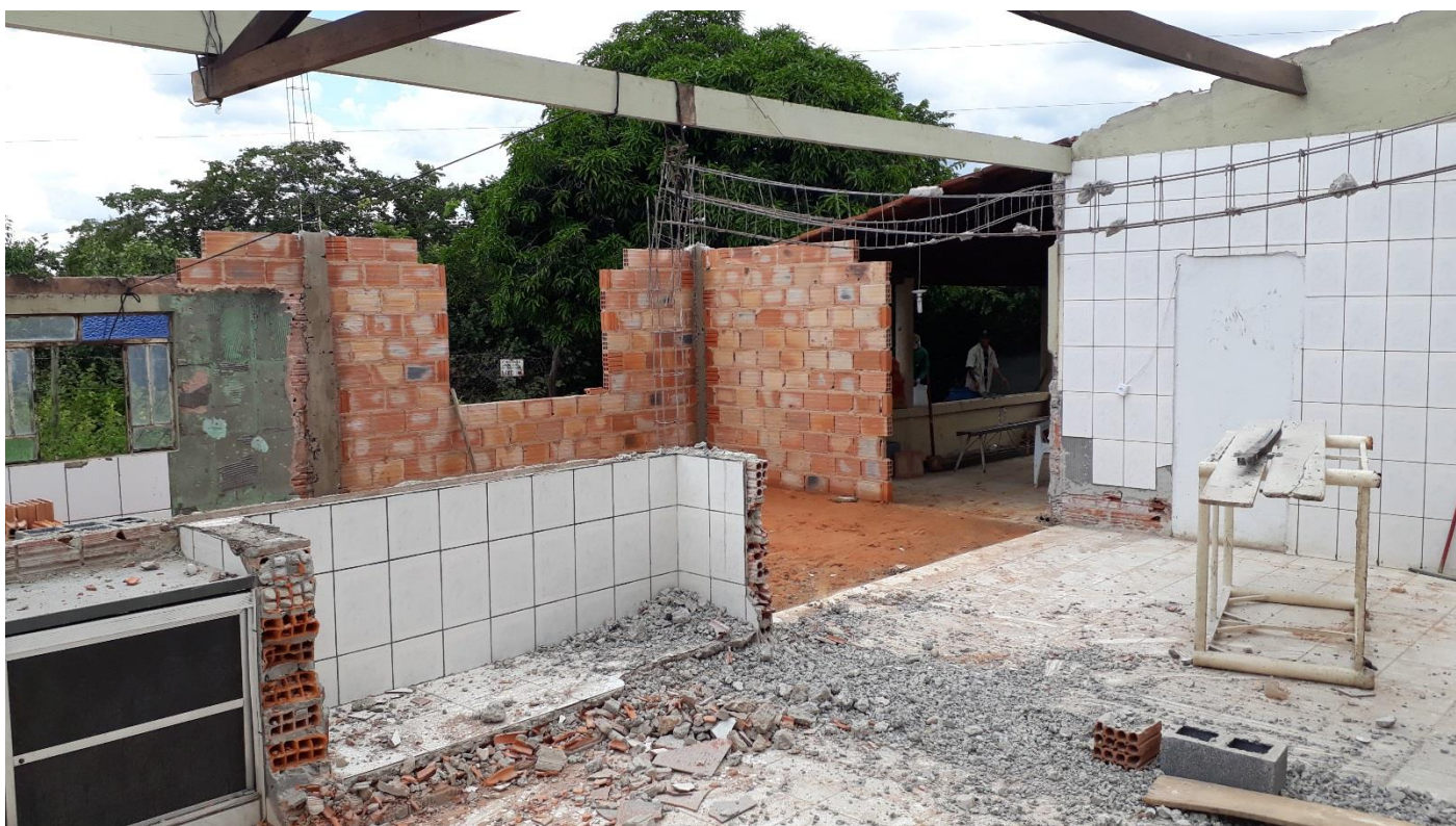
REFORMA DA C.T – CONSTRUÇÃO DA COZINHA INDUSTRIAL
