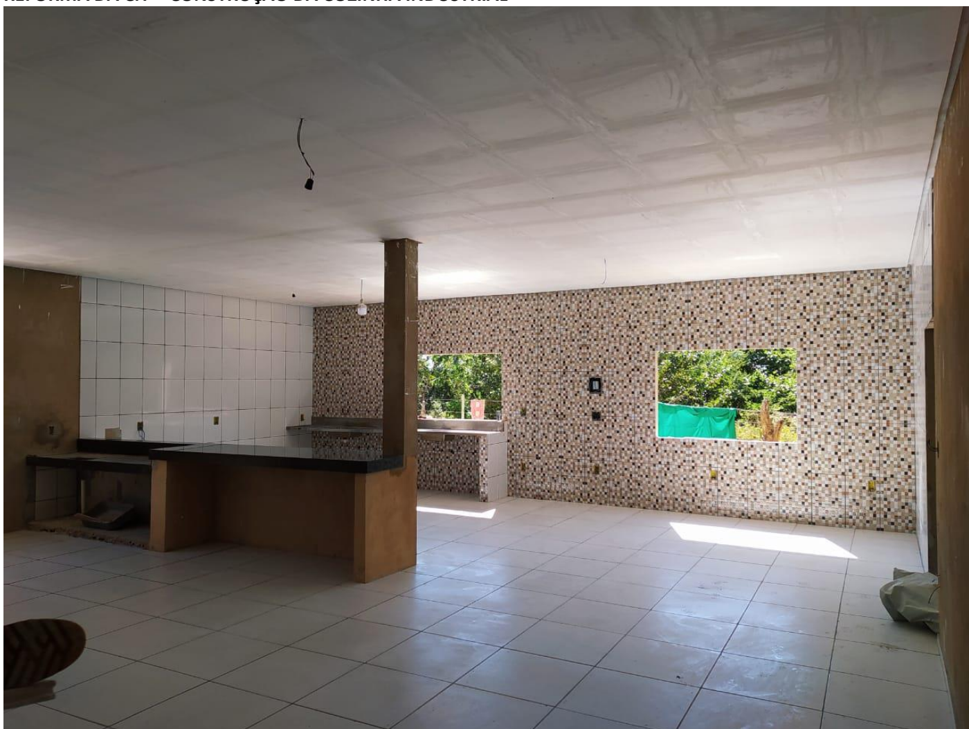
PARTE DE ACABAMENTO
