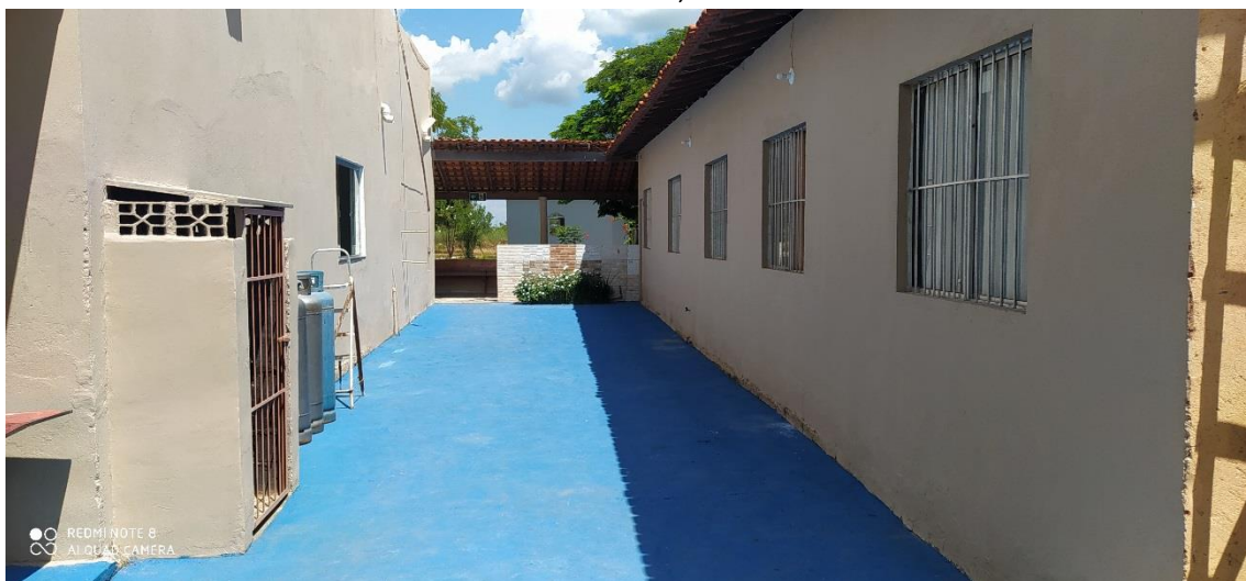
Serviço de pintura da unidade de acolhimento na BR 251 KM509,9
