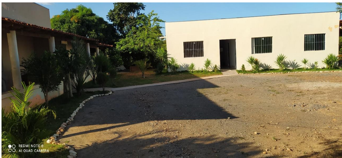
Vista lateral da unidade de acolhimento na zona rural na BR 251 km 509,9
