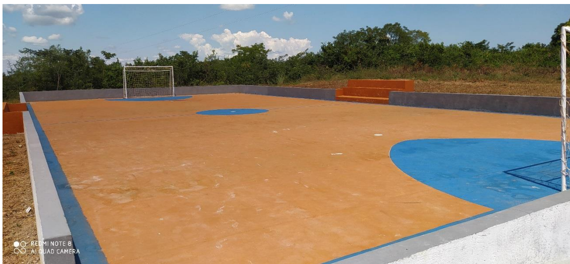
Conclusão da construção da quadra poliesportiva na unidade de acolhimento na BR 251 KM509,9
